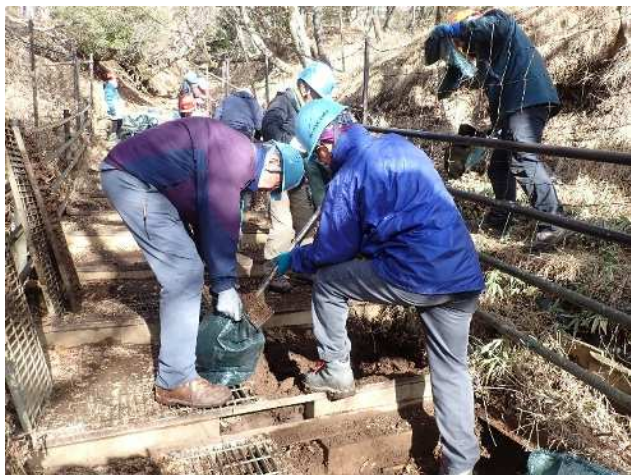
掘り出した土を土のう詰めする
