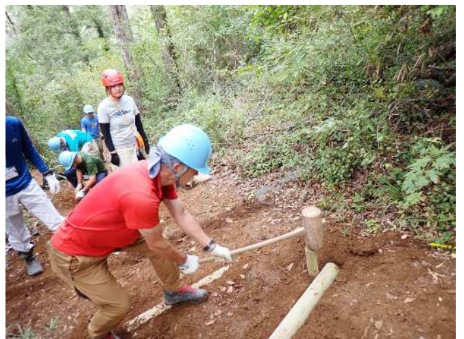
杭を打つ時は周囲の安全確認が大切
