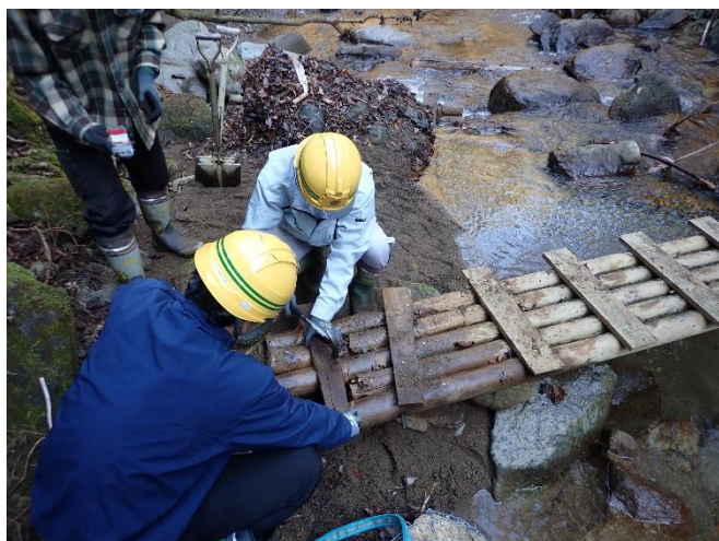
横板の打ち直し
