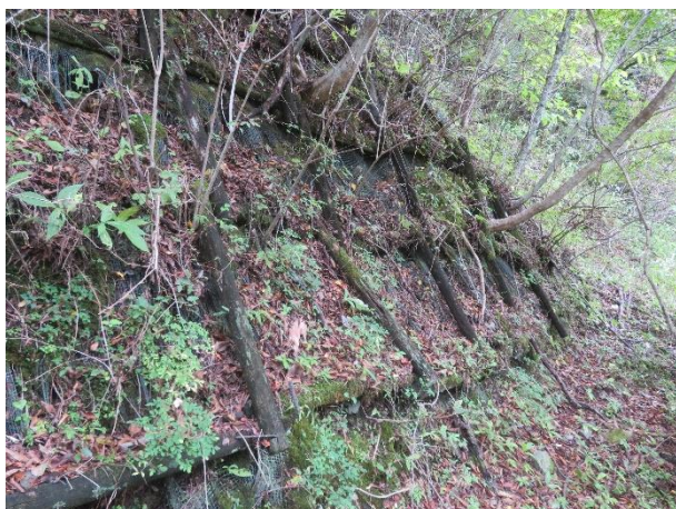
木製の法面補強
