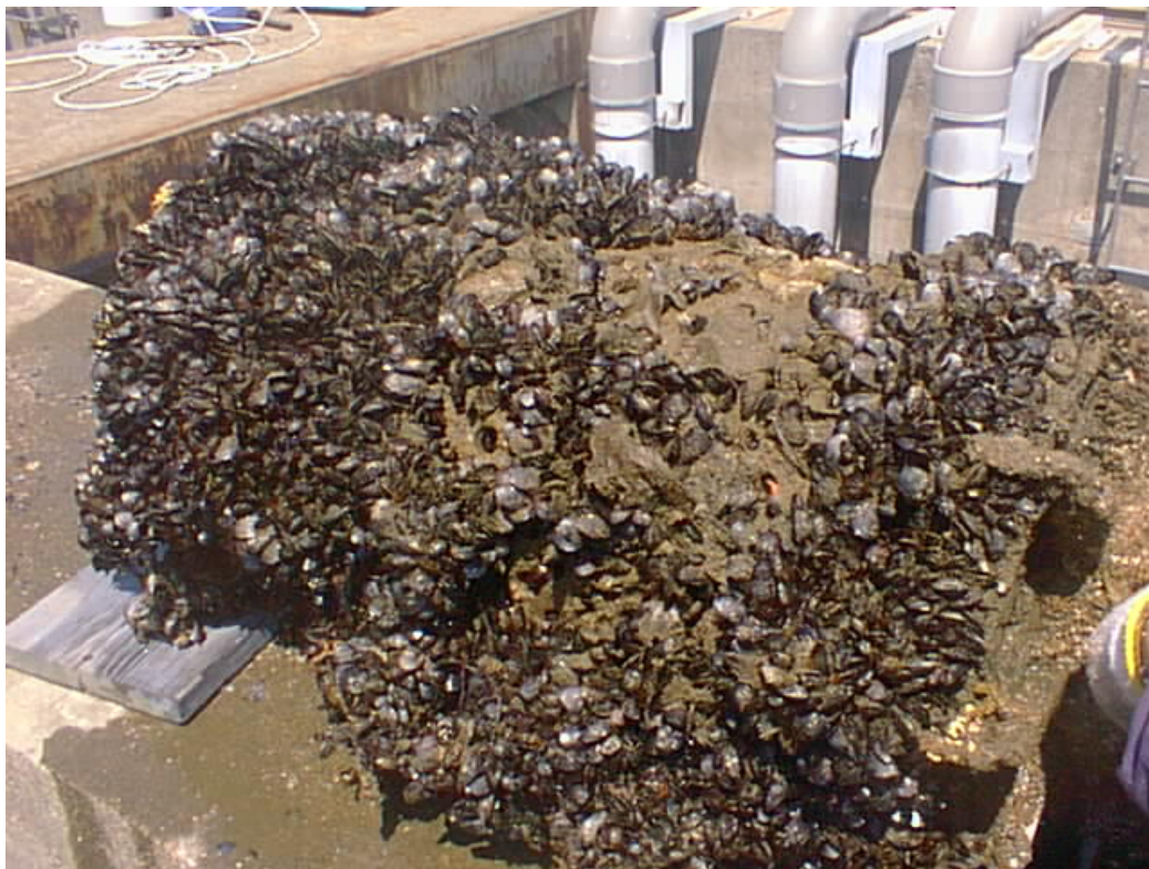
写真2 ストレーナー掃除前
