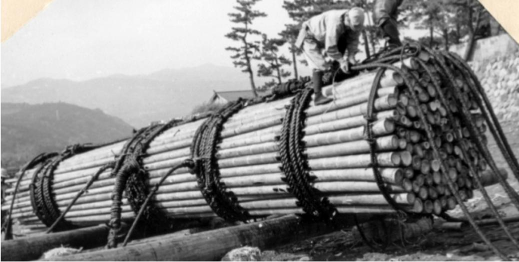
写真2 孟宗竹を用いた定置網の台浮子（昭和29年）
