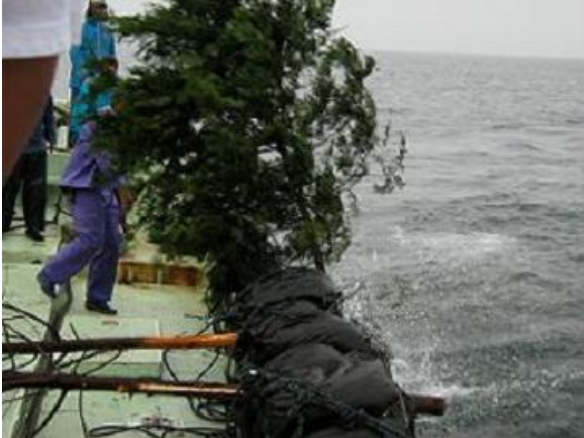
写真1：間伐材魚礁の設置作業
