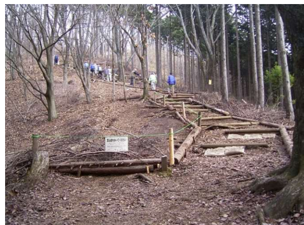
11月の作業終了後
