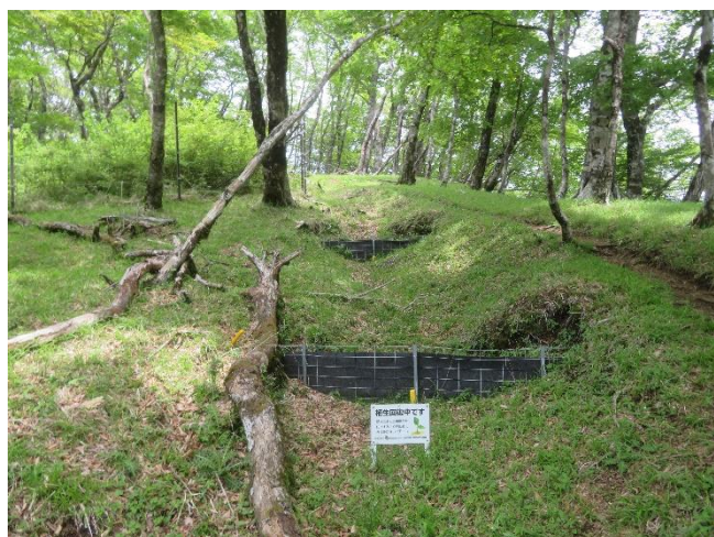
土壌流出を防止するための施設
