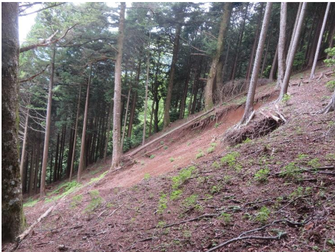
登山道脇の谷筋の崩落箇所
