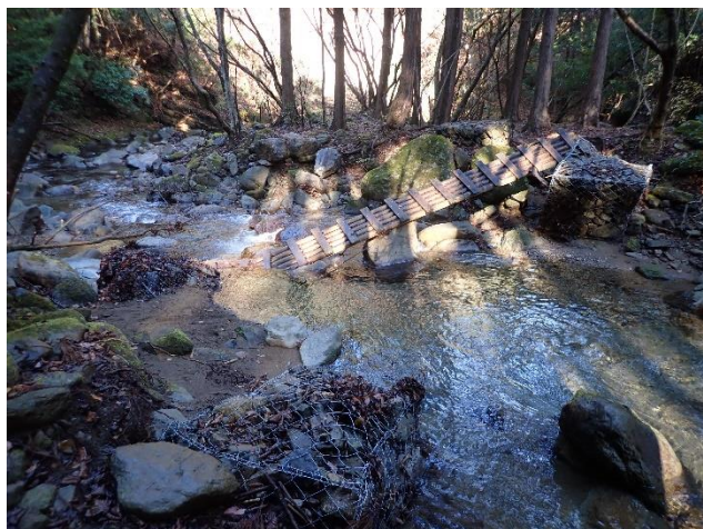
落ちた木橋 （写真左：不動尻側から）
