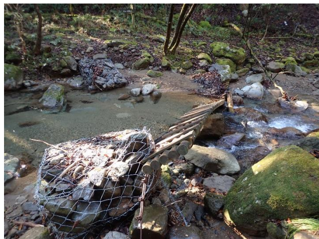
写真右 谷太郎林道終点側から）
