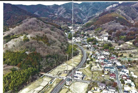
写真3 市道との交差部
