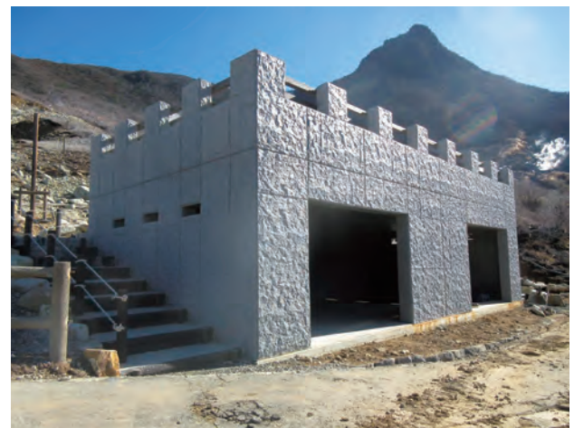
写真2-1 2号シェルター完成（外観）
