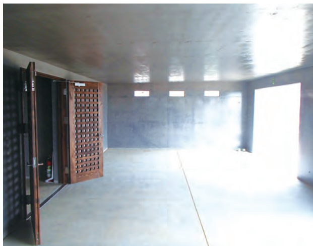
写真 2-2 2号シェルター完成(内部)
