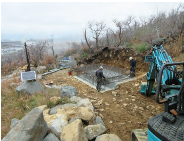
写真1 施工中の3号シェルター
