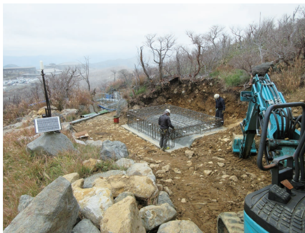
写真1 施工中の3号シェルター
