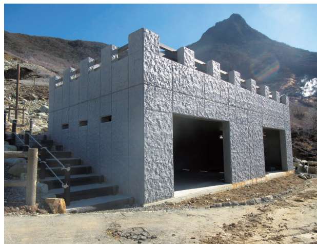
写真2-1 2号シェルター完成（外観）
