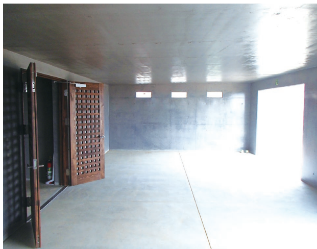
写真 2-2 2号シェルター完成(内部)
