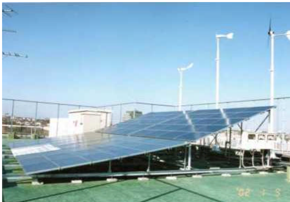
学校屋上に設置されたクリーンエネルギー（太陽光・風力）市民共同発電所
