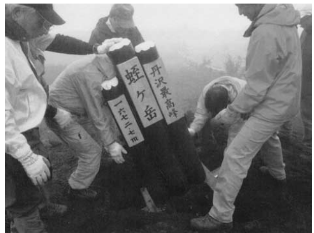
写真2 登山道補修隊で山頂名板を設置（蛭ヶ岳）
