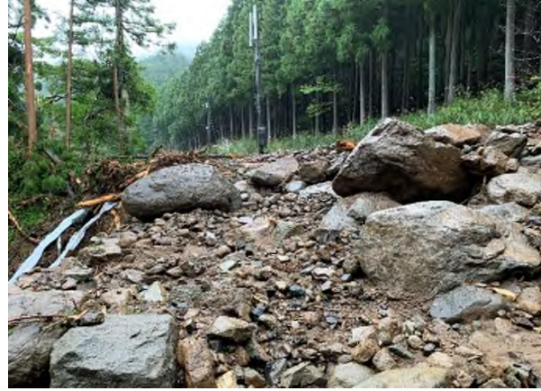
県道70号(秦野清川)26.4kp付近 法面崩落
