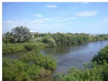
Kanagawa Prefect. 河床掘削・樹木伐採の実施
