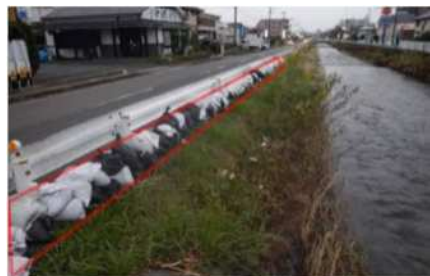
溢水箇所などへの 高上げコンクリート工事の実施
