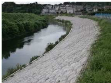
老朽化護岸の整備
