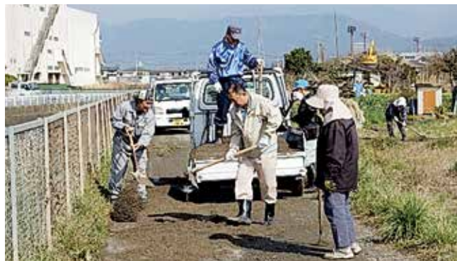
地域ぐるみで実施する農道の補修作業（小田原市）
