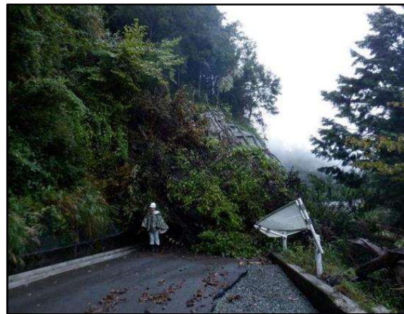
南箱道路 No186付近 法面崩落
