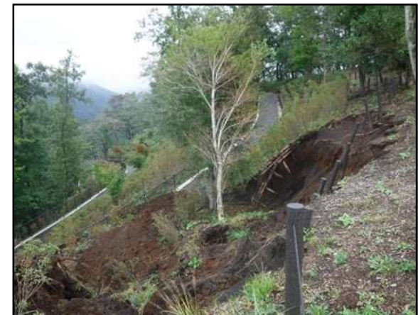
山北つぶらの公園 つつじ山園路 法面崩落
