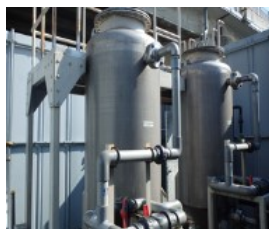
地下水汚染対策
