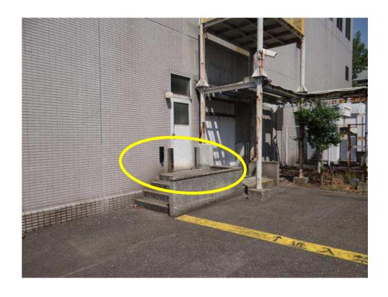
(キ)計器用圧縮空気・圧縮機・ホルダーに対する津波(浸水)対策実施事例 南海トラフ地震の津波想定を基準にし、対策が必要なものについては、更新に 合わせ嵩上げ(40cm)を実施した事例である。
