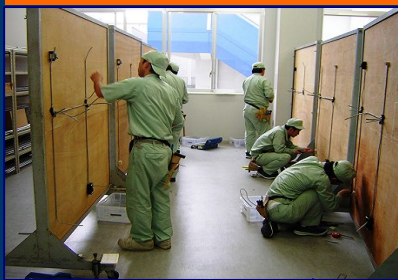
電気工事施工実習風景
