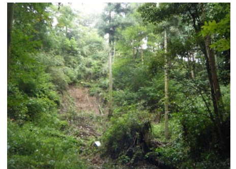
土砂が崩れ観察路が見えなくなっている
