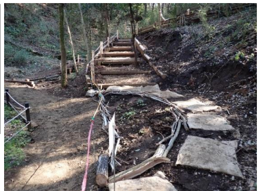
新しい通路(N9付近から)
