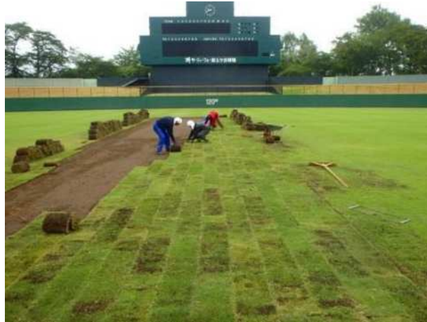
硬式野球場外野部分の大規模芝補修による高水準の競技環境の提供
