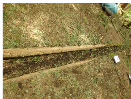
高校生が設置体験した水切工
