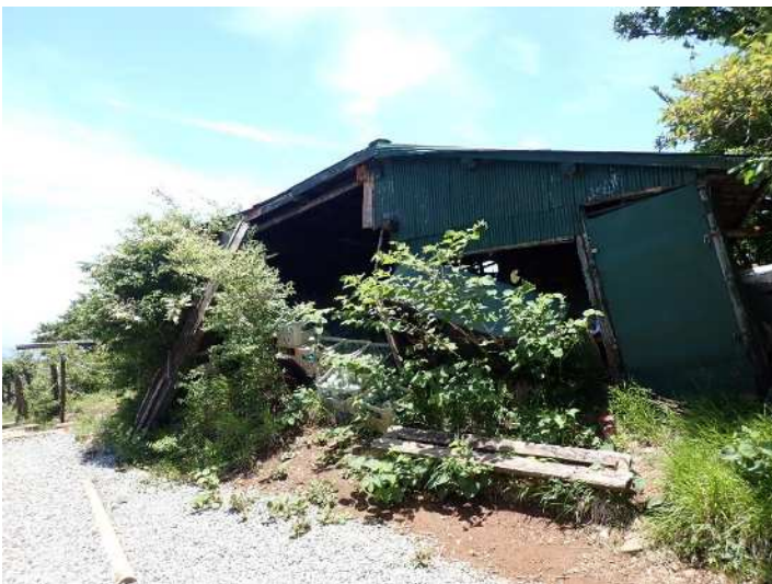
解体前の新大日茶屋（令和4年6月撮影）
