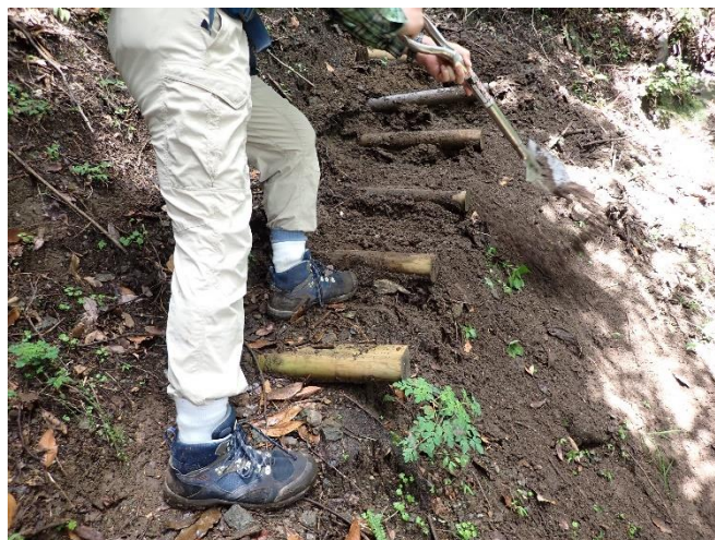
丸太階段の掘削
