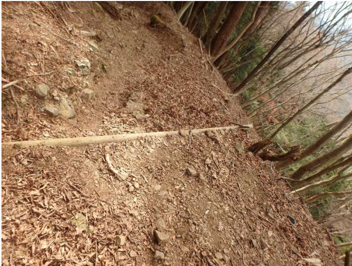
水切工掘削前
