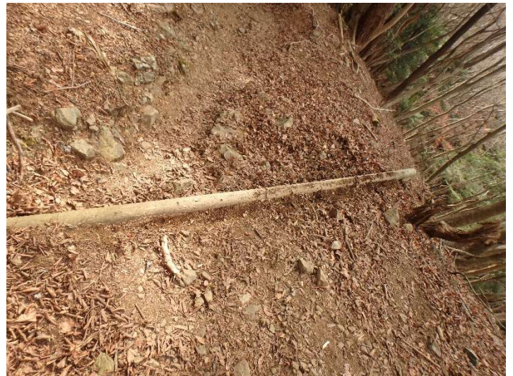
水切工掘削後
