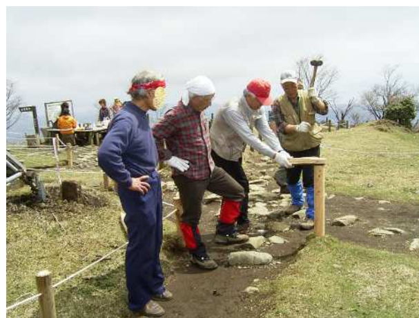
杭の打ち込み作業
