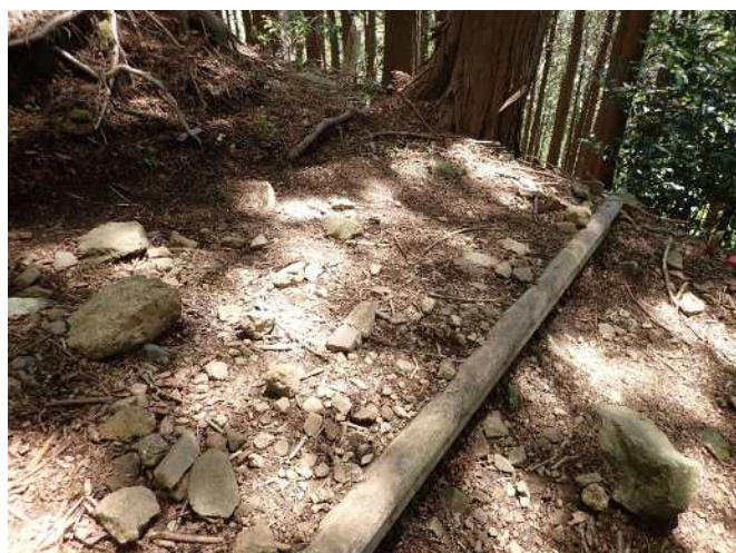
水切工（雨水排水の設備）の土砂かき出しの作業前と後
