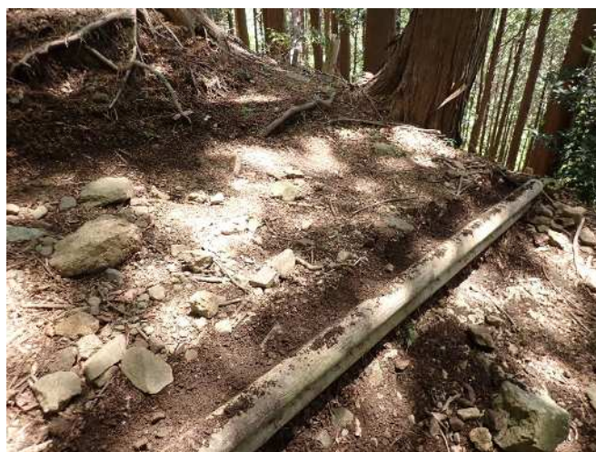
水切工（雨水排水の設備）の土砂かき出しの作業前と後
