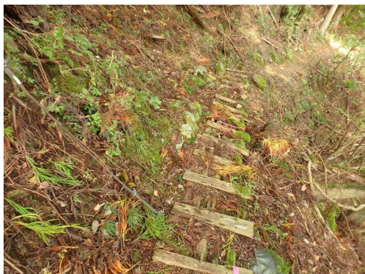
栈道、工事前（'19年10月撮影）
