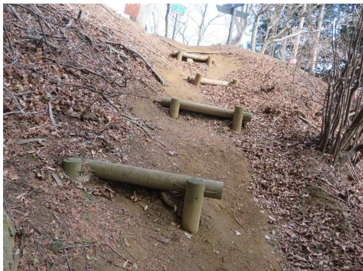
丸太階段、工事前（'19年10月撮影）
