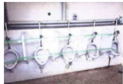
<トイレ尿石除去剤洗浄 >
