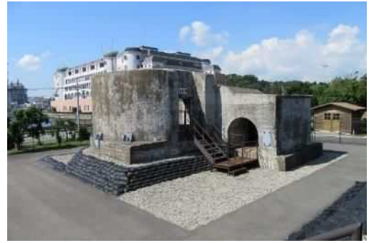
東京湾第三海堡構造物（観測所）
