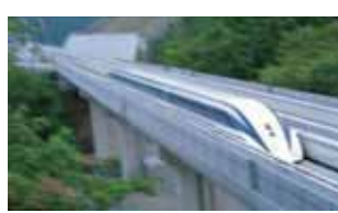
走行試験が行われている「山梨リニア実験線」（山梨県都留市）
