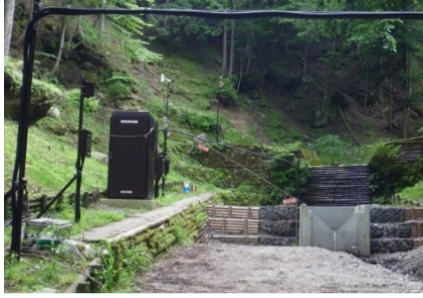
森林モニタリング(西丹沢ヌタノ沢試験流域) H24年7月:モニタリング施設整備翌年、柵設置前
