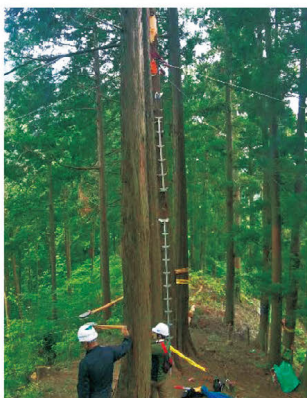
▲架線の設置作業の様子
