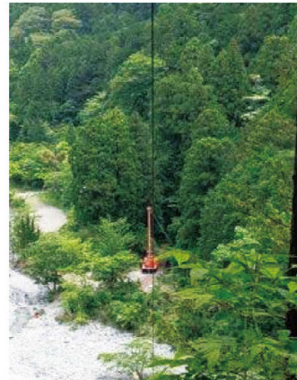
▲先柱から元柱を見た様子
