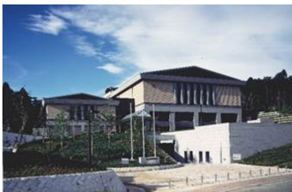
【施設の外観写真】
