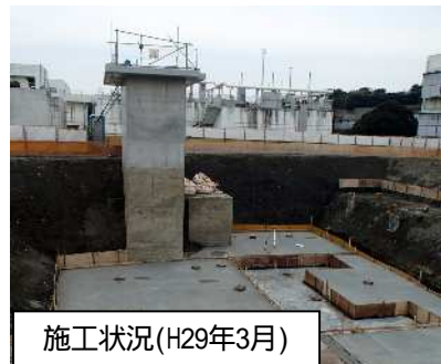
相模川流域下水道(左岸処理場) 第一分水槽耐震工事 (別位置へ施工)
