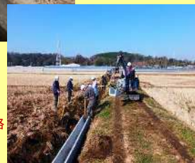
直営施行による水路 の更新工事
