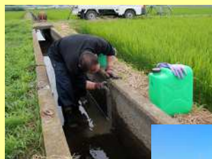
水路の目地詰め
