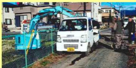
重機を利用した水路土砂浚渫作業の様子
