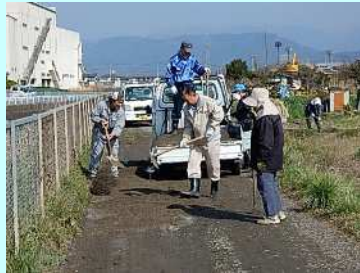
農業用水路の管理通路の補修
