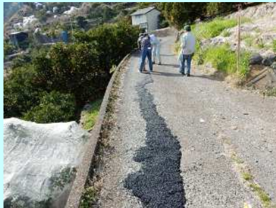
樹園地農道の補修
