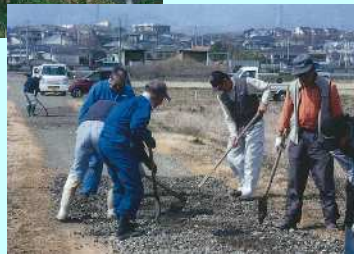
農道の維持補修
