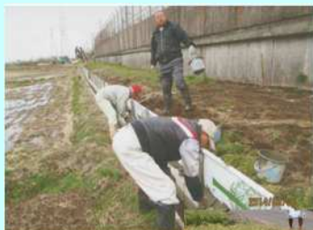
水路の点検 及び初期補修
