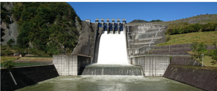
ダムゲートからの放流
