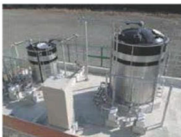
山梨県大月市にある桂川清流センター内に、凝縮材によるリン除去設備を設置した。
