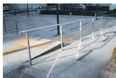
車いす用スロープと点字ブロック
