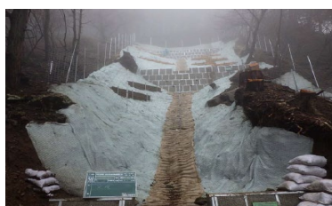
水源林の基盤整備
